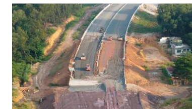
Cao tốc Biên Hòa – Vũng Tàu Dự kiến hoàn thành cuối 2025
